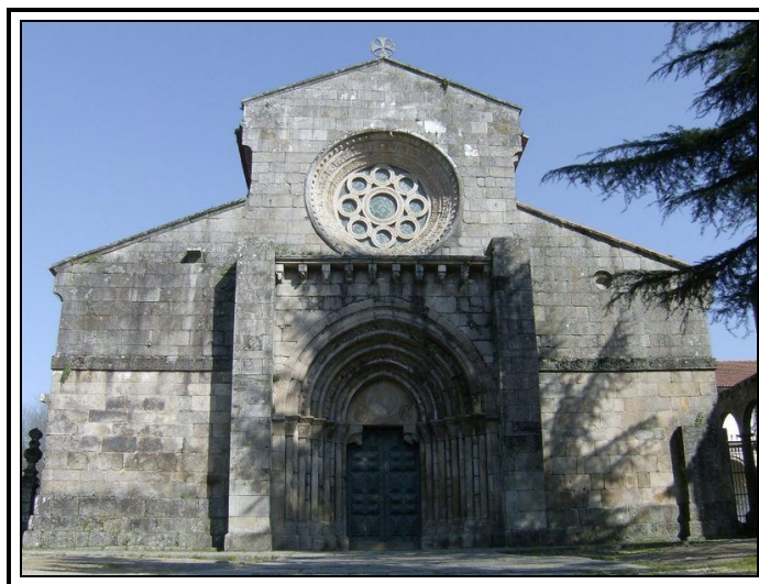
Fig. 2.5 – Igreja do Salvador Paços de Sousa (Penafiel): fachada românica típica
