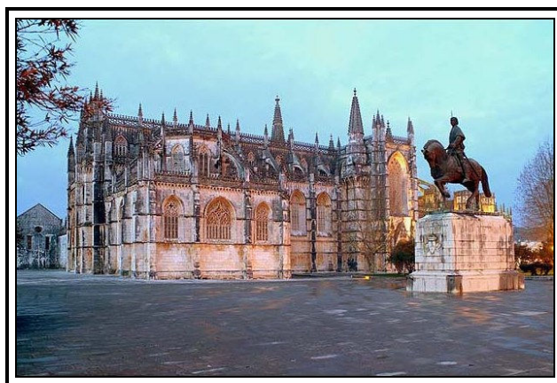
Fig. 2.9 – Mosteiro da Batalha (Santa Maria da Vitória)
