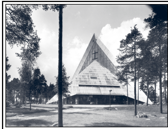
Fig. 2.23 – Igreja de Hyvinkää (Finlândia)
