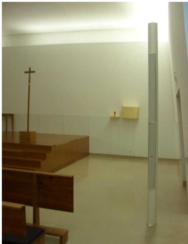
Figura 4.37. – Capela 3+4 (da Morte de Jesus), altifalantes da marca “Bose” responsável pela difusão da palavra [foto do autor].
