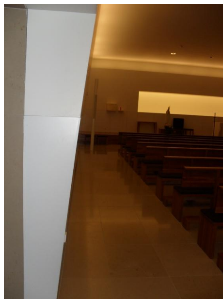
Figura 4.28. – Capela 1 (do Santíssimo Sacramento), inclinação da parede para evitar as reflexões múltiplas [foto do autor].
