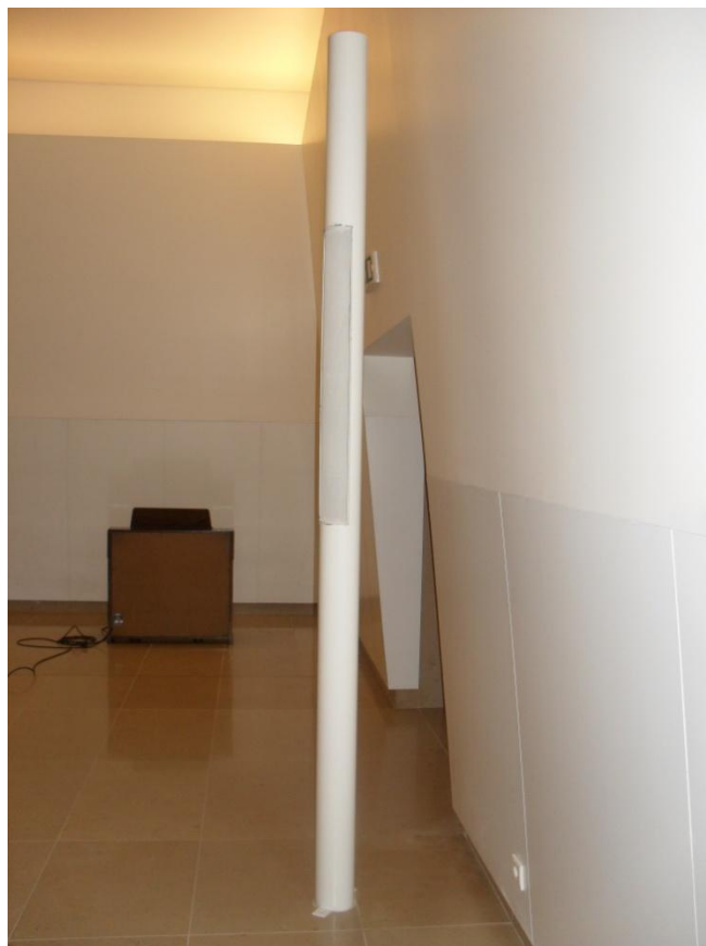
Figura 4.33. – Capela 1 (do Santíssimo Sacramento), altifalante da marca “Bose” responsável pela difusão da palavra [foto do autor].
