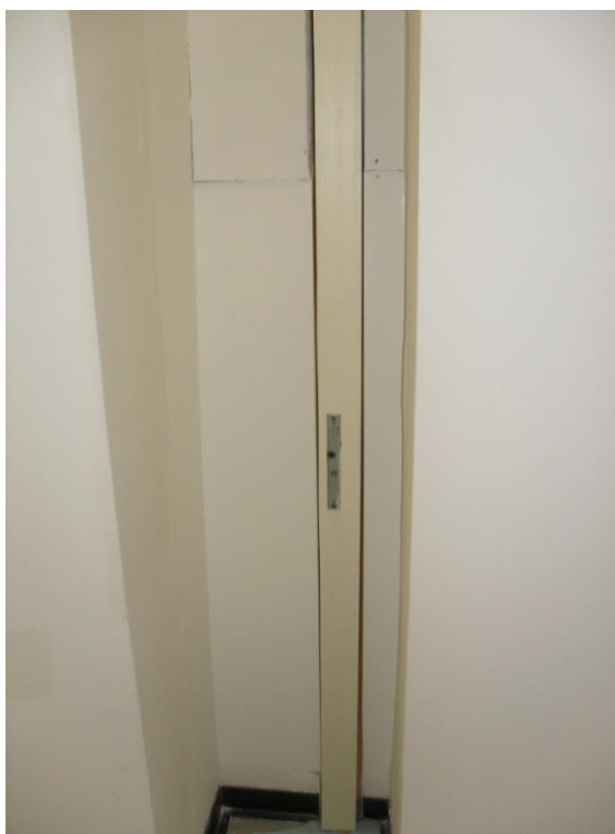
Figura 5.40. – Pormenor da ligação do último painel da divisória amovível da capela 3+4 com a abertura de passagem da zona técnica para esta.
