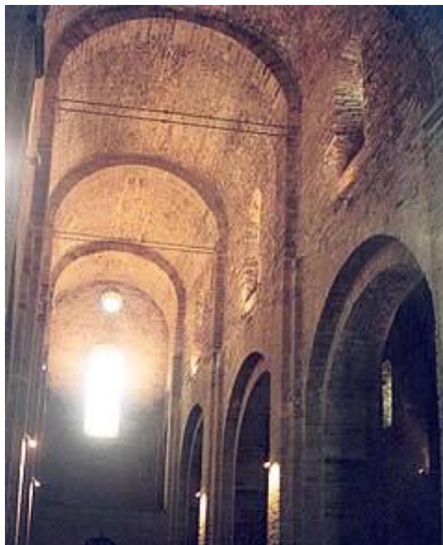
Figura 3.2. – Tecto abobadado em pedra igreja de S. Vicente de Cardona, Espanha [34].
