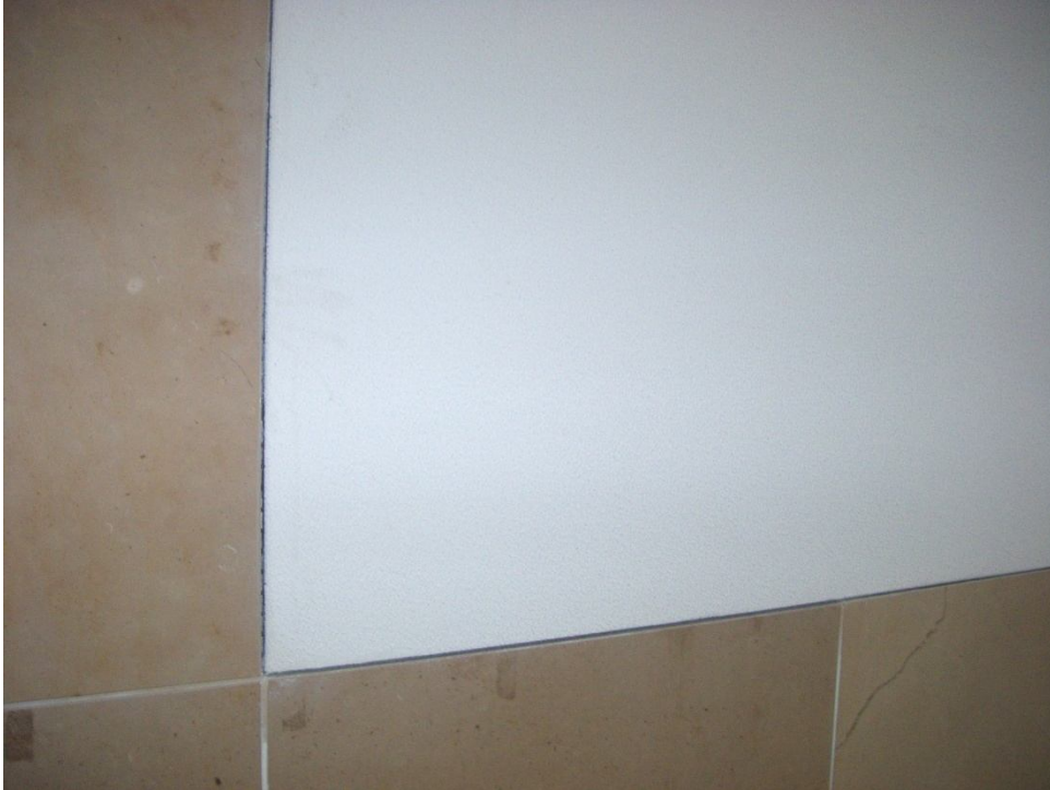
Figura 4.18. – Parede revestida com “Akustaplan” (parte branca). [Foto do Autor]
