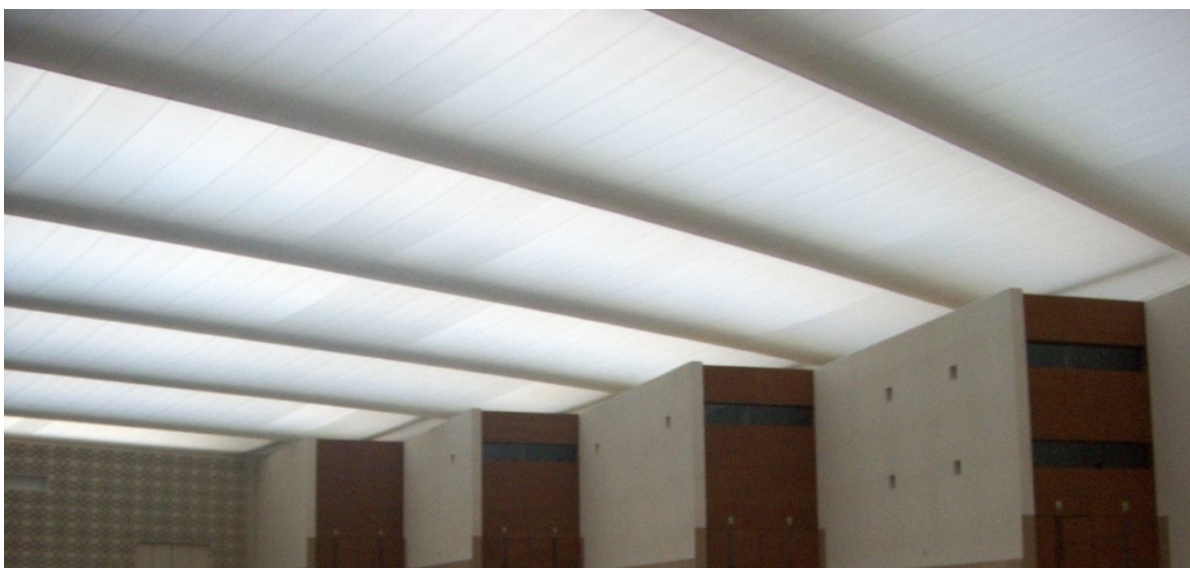
Figura 4.8. – Pormenor da membrana translúcida que tapa a cobertura e permite entrada de luz [Foto do Autor]
