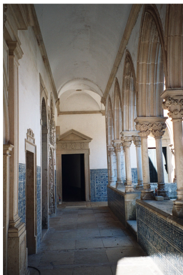
Fig. 3.27 - Galeria do claustro do Cemitério (Tomar)
