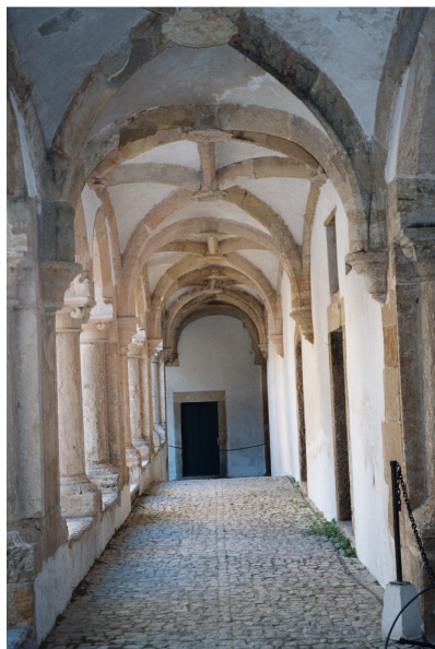
Fig. 3.29 - Galeria do claustro da Hospedaria (Tomar)
