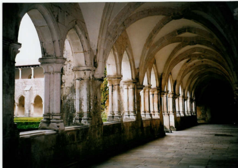
Fig. 3.21 - Galeria do claustro D. Afonso V (Batalha)
