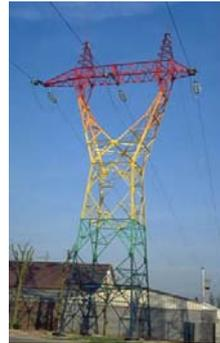
***Apoios de alinhamento*** suportam unicamente os condutores e cabos de guarda quando os dois vãos adjacentes estão no prolongamento um do outro. Esforços verticais e transversais.
