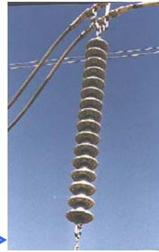
Para tensões de serviço superiores a 60kV, e por vezes mesmo para tensões inferiores, os isoladores rígidos são difíceis de montar e demasiado frágeis devido às suas dimensões, logo pouco seguros. Assim, foi necessário desenvolver novos tipos de isoladores tendo surgido os isoladores suspensos compostos por vários elementos reunidos em forma de cadeia. Estes isoladores podem ser de porcelana ou vidro.
